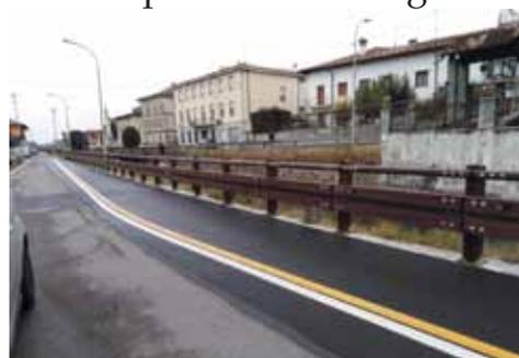
fino al semaforo all'incrocio di via Aldo Moro, è stata rialzata la protezione esistente in legno in quanto irregolare e non a norma. Con questo intervento si è ridotta la dimensione della carreggiata e quindi si è resa necessaria l'istituzione di un senso unico dal ponte sul Naviglio fino all'incrocio di via Aldo Moro. L'intervento prevede anche la regolamentazione della percorribilità del tratto veicolare che viene limitato con istituzione della zona 30 (limite di velocità 30 km orari).
